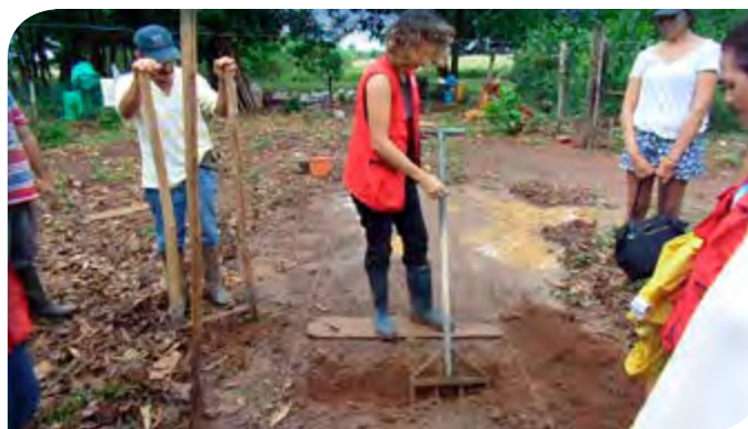
Imagen 2. Doble excavación. Fuente: Farmer to Farmer Orinoquia
